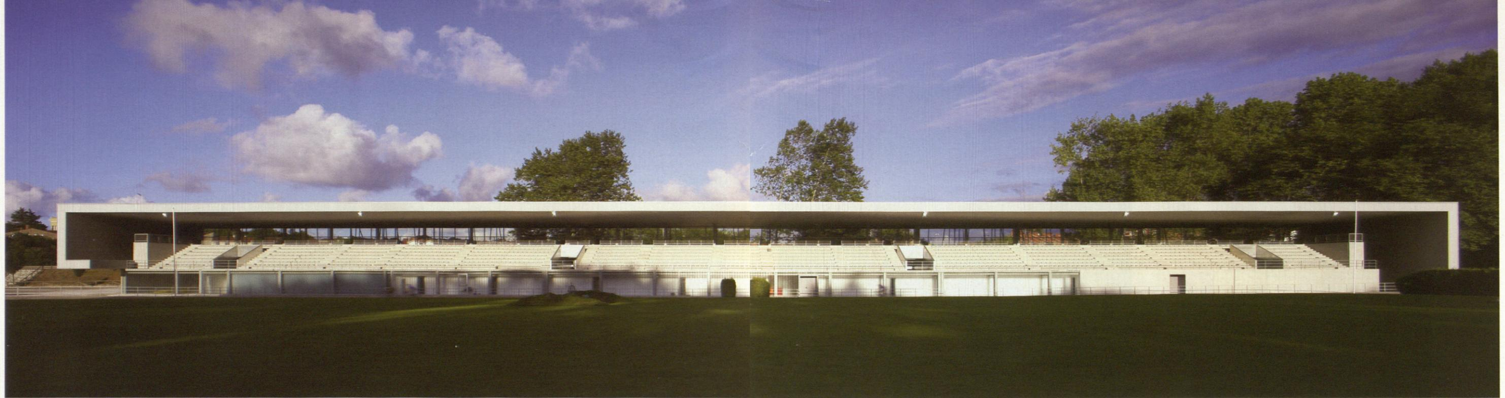
Para la concepción del proyecto se partió de la base de respetar al máximo la zona verde existente. La fachada este refleja la vegetación mediante un juego de pilares metálicos formando un tamiz de juncos y un cerramiento compuesto por chapas de acero galvanizado plegado en U que cambian de posición, creando así un filtro para la luz de la mañana.
